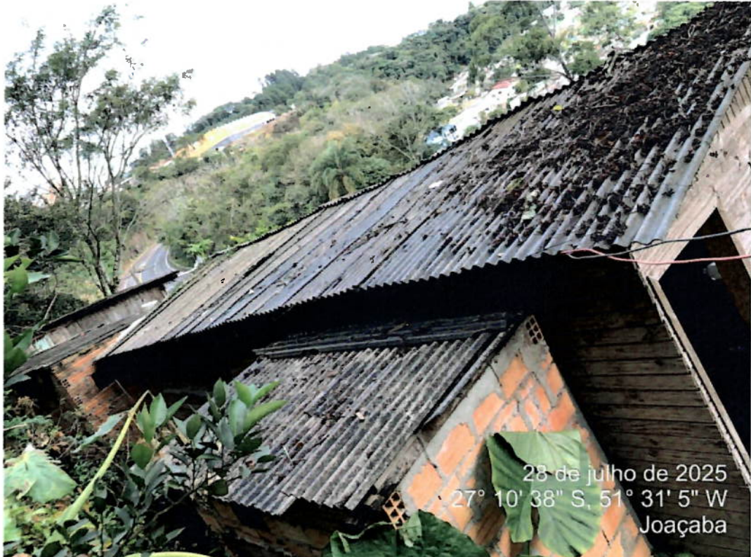
Foto 11 – Vista do telhado abaulado
