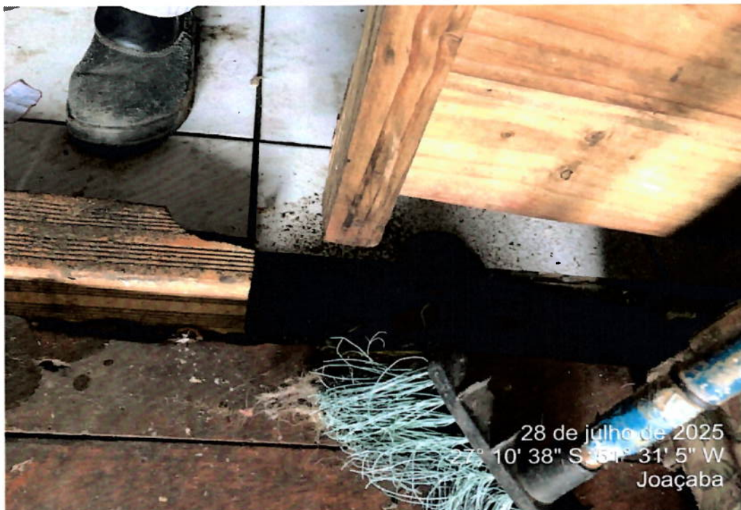
Foto 10 – Vista do descolamento da parede com o assoalho
