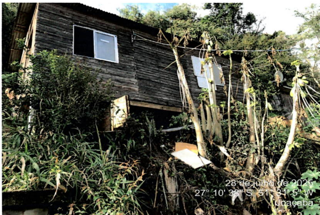
Foto 1 – Vista frontal da edificação para a via
